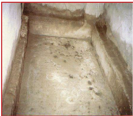
SUNKEN SLAB WATERPROOFING
